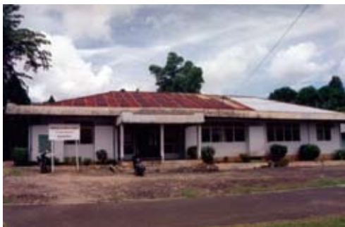
Gedung Pengadilan Agama Sanggau sebelum pembangunan
