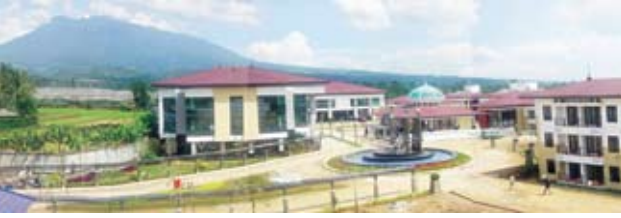
Pembangunan Gedung Puslitbang Diklat MA RI, Ciawi Bogor.
