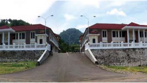
Pembangunan Gedung Pengadilan Negeri Cibadak.
